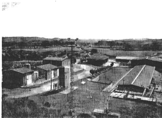
Estación de Tratamiento de Agua Potable de Los Guillemos. / N.E.
