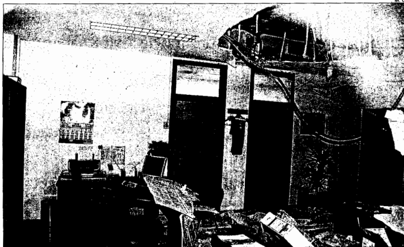
El falso techo que se desprendió causó destrozos en el mobiliario, aunque no provocó daños personales
